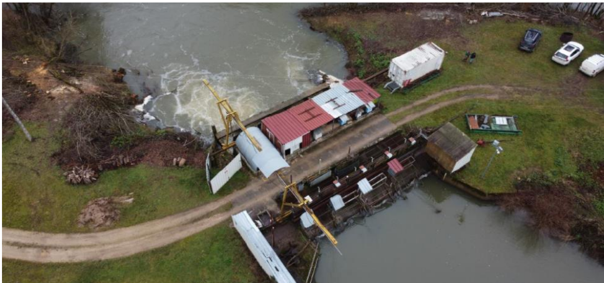
Centrale initiale avant démantèlement
