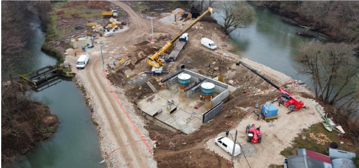
Construction de la nouvelle centrale en cours (génie civil et pose des turbines)
