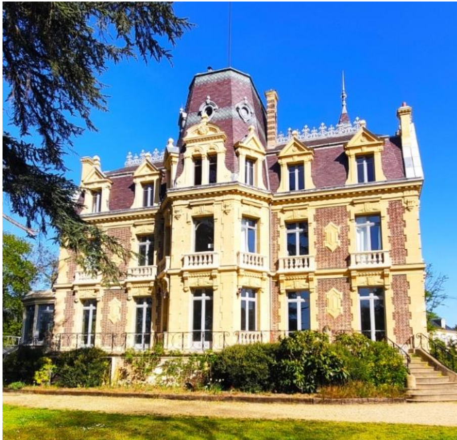
Photographie de la toiture post-travaux
