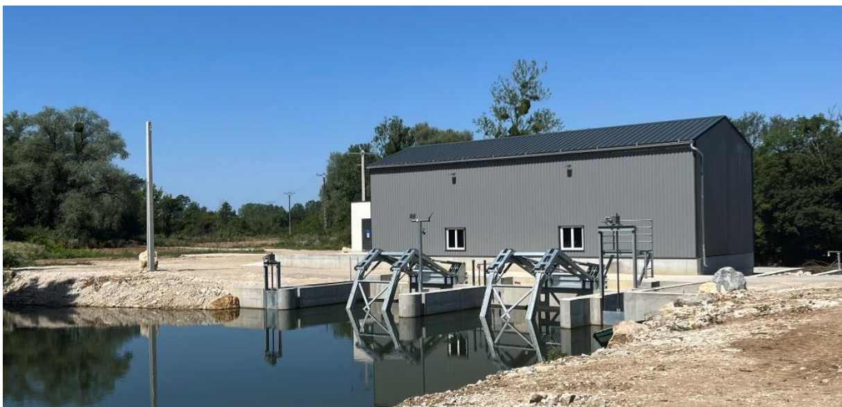
Bâtiment de la nouvelle centrale
